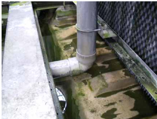
アクアクリア設置前の冷却塔の 下部水槽に水藻発生あり
