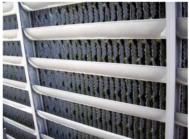
設置後 3.5 ヶ月冷却塔の水藻(H23.2.7) 水藻は完全に自然に落ちた。(効果大)
