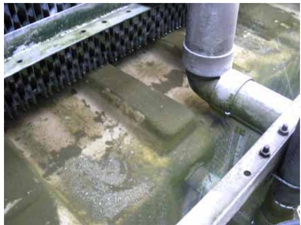
アクアクリア設置 3.5 ヶ月後 水藻は枯れて冷却塔より落下したスケールが 底部に溜まる
