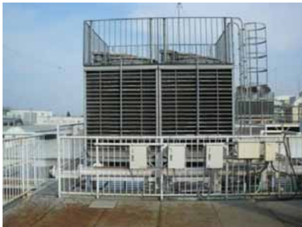
300RT の冷却塔
