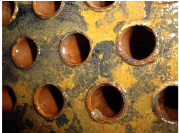
設置後 3.5 ヶ月コンプレッサーの熱交の開放 点検でスケール・スライムの発生無しを確認
