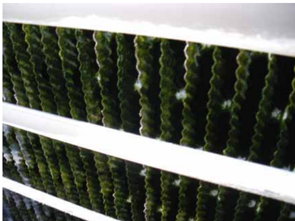
設置前冷却塔の水藻(H22.10.22) 水藻用薬品利用にかかわらず効果なし 冬場にも水温 30～35 あり
