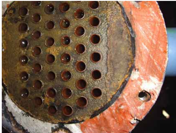
設置後 3.5 ヶ月オイルクーラー 開放点検でスケール・スライム付着なし
