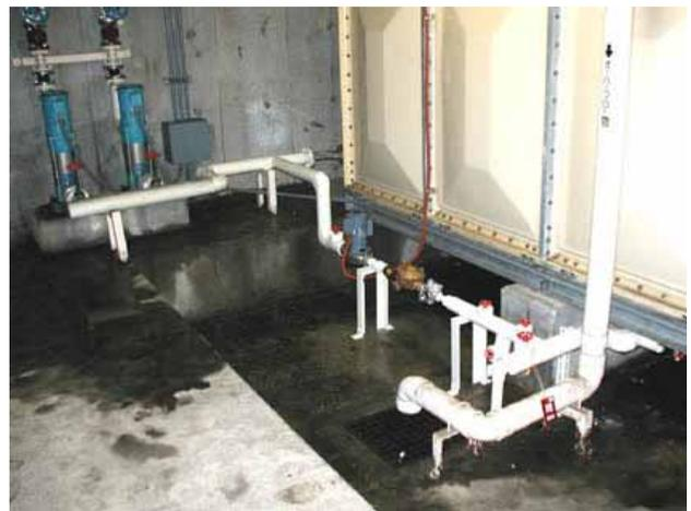
揚水ポンプ吸入側より水を取り出し、ポロー処理してブロー管より水槽へ入れる独立循環方式
